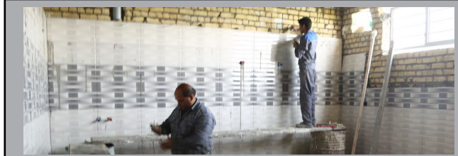
عملیات احداث غسلخانه جدید
